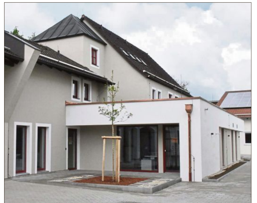
Viel Licht fällt in die Büros des neuen Kundenzentrums der Stadtwerke.
