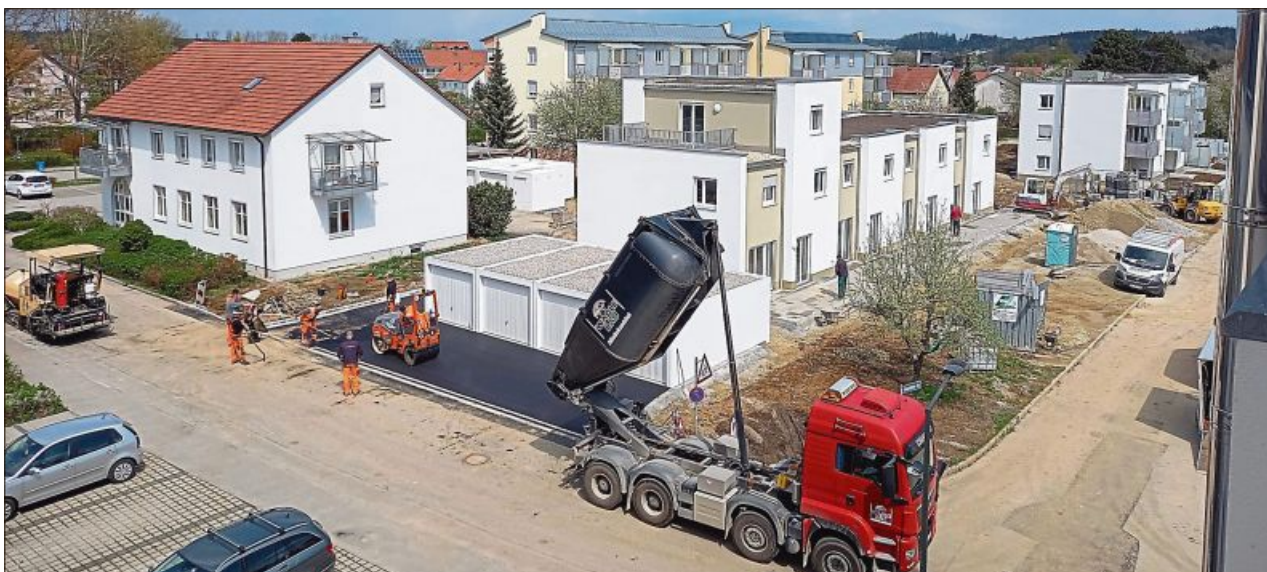
Zeitlich lief beim Projekt alles nach Plan, das Wetter verzögerte nur die Fertigstellung der Außenanlagen ein wenig.
