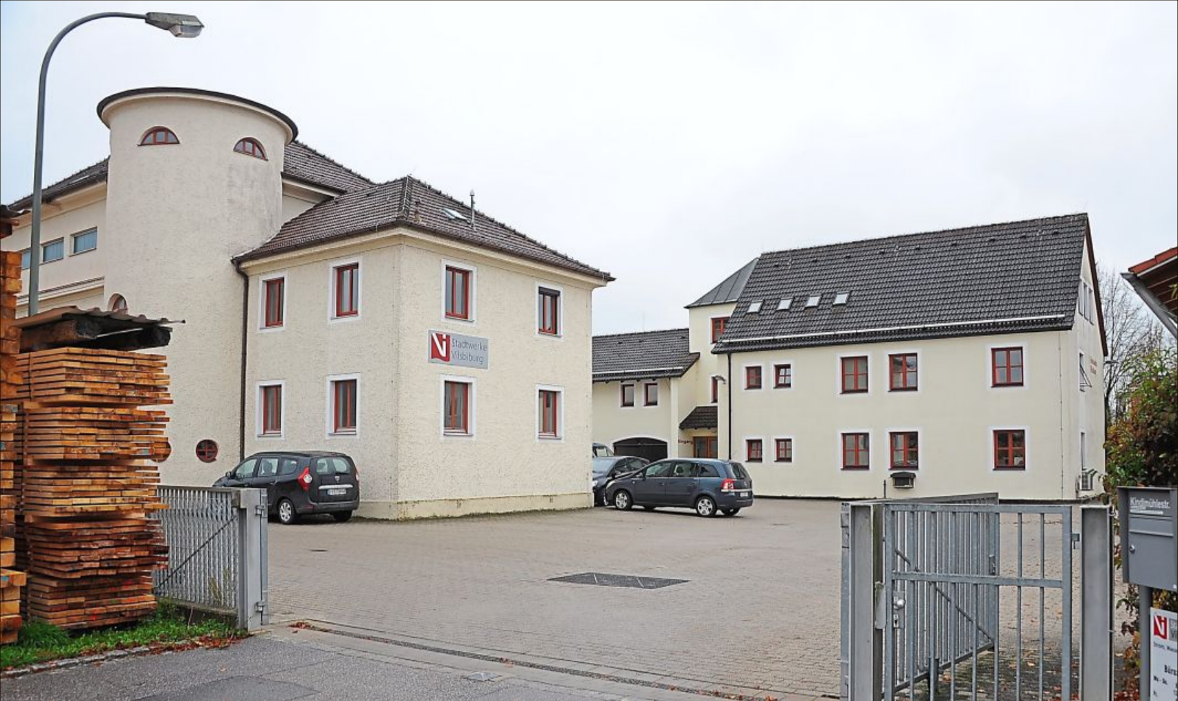
DER AKTUELLE GEBÄUDEKOMPLEX DER STADTWERKE VILSBIBURG wurde Mitte der 80er Jahre umgebaut, im Oktober 1985 wurden die Büros und Werkstätten offiziell in Betrieb genommen. In der Mitte des Areals befindet sich das ehemalige OBAG-Schalhaus, das bereits dort stand, bevor drumherum die neuen Stadtwerke angesiedelt wurden. Auch das heutige Verwaltungsgebäude (rechts) wurde damals aus einem bereits bestehenden Haus umgebaut. Foto: Michael Betz
